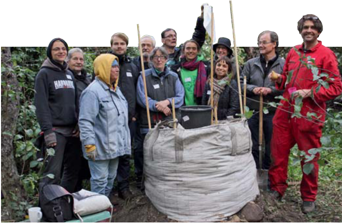
Der Bau des Grauwasserturms aus größtenteils recycelten Materialien mit tatkräftiger Beteiligung aller Teilnehmenden bildete den Abschluss des Workshops.
